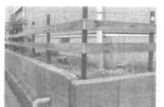
フェンス設置後
